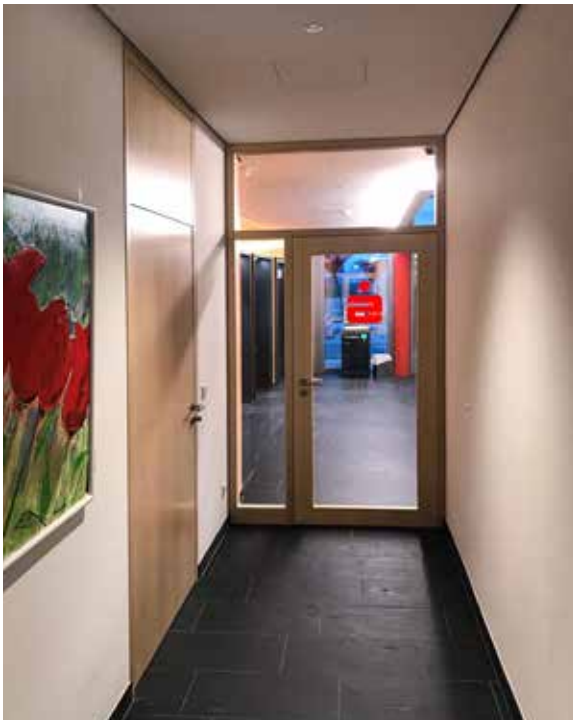
KÖ-PRBILD-TM0008 Türelement links: Bürotür, wandflächenbündig, in die Leibung öffnend und Oberblende mit Gegenfalz Türelement rechts: Glaswand mit F30-Brandschutzverglasung
