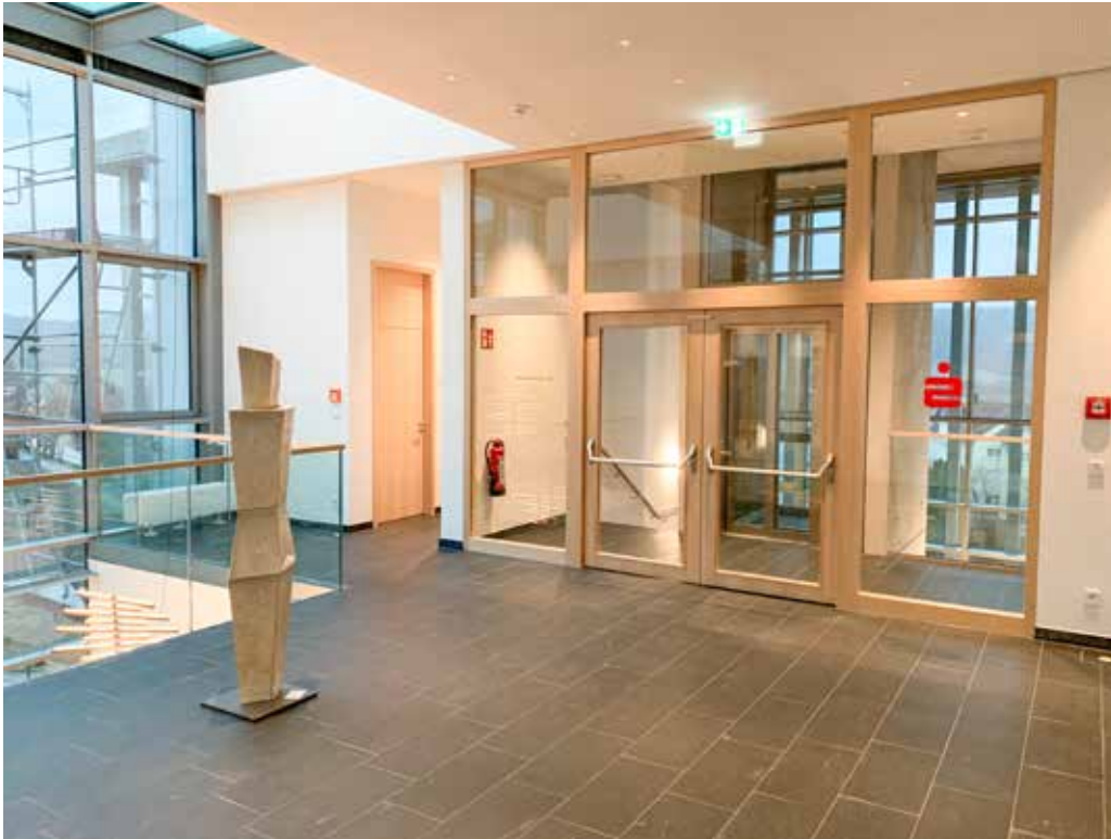
KÖ-PRBILD-TM0003 Glaswand mit F30-Brandschutzverglasung.
